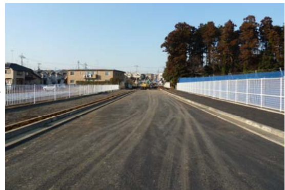
開通前（東野側から撮影[H30.2]）
