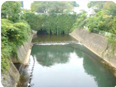
帷子川今川橋上流落差工
