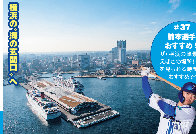
長さ430m、幅70mを誇る巨大な棧橋
