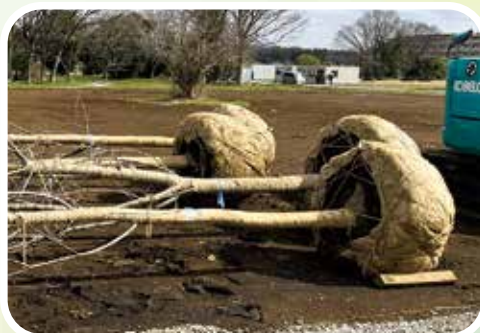
移植対象の樹木を丁寧に掘り上げ、根鉢（根と土の塊）を大切に包み移植先に運びます。
