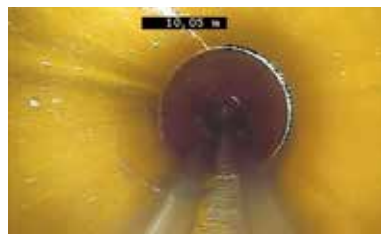
▲カメラでみた下水道管内部
