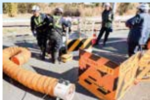
▲下水道管の点検状況
