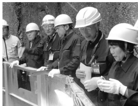
雨水幹線整備工事現場の視察
