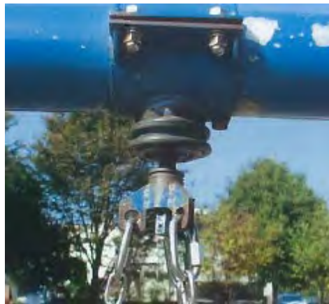
図 2-17 タイヤブランコ吊金具の例
