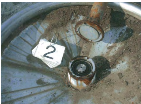
図 2-1 5 回転遊具・点検作業中① ベース部：上部カバー及び支柱を外す。
