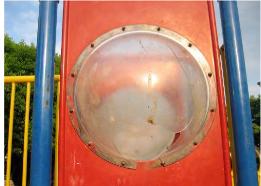
図 2-4 2 割られたドームパネル
