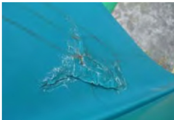
図 2-9 FRP 破損の例
