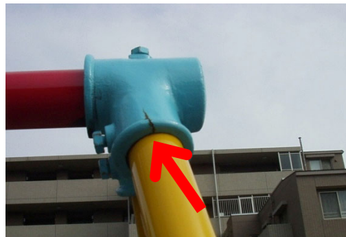
図 2-2 6 梁がボルトで固定されている例
