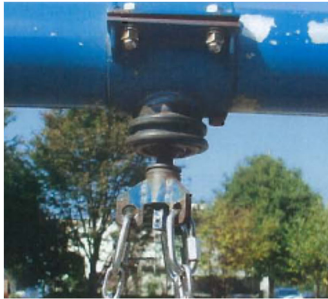
図 2-17 タイヤブランコ吊金具の例
