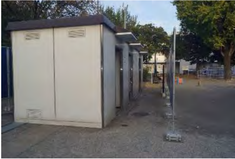
戸部公園自由広場 トイレ(目隠し)
