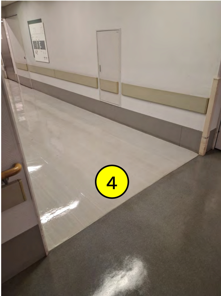
地下1階④ (サービス廊下入口)
