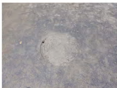
はまっこトイレマンホール（撤去）
