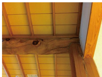
写真5-11 ねじれ対策の補修
