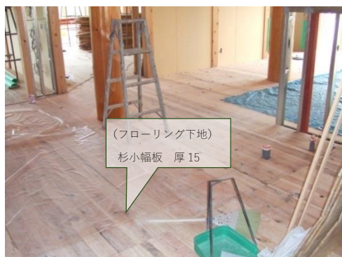
写真 4-9 床下地への端材利用
