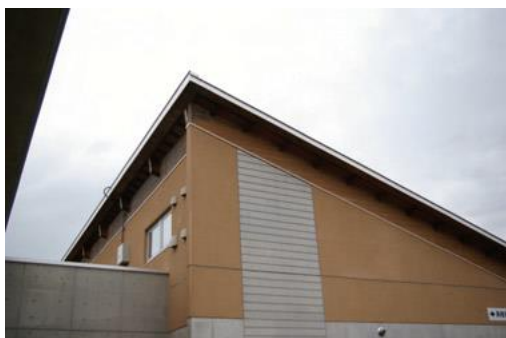
写真5-10 片流れ屋根棟部
