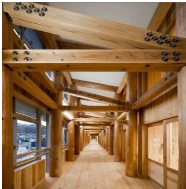
写真 4-20 内部の木材継手状況
