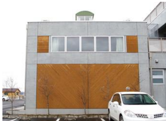
写真 5-6 外壁木部の塗料落ち有り
