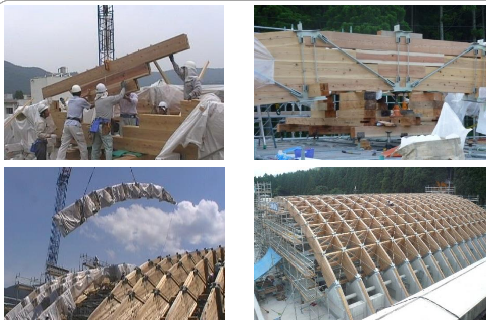
写真 4-16 複合アーチばりの施工現場
