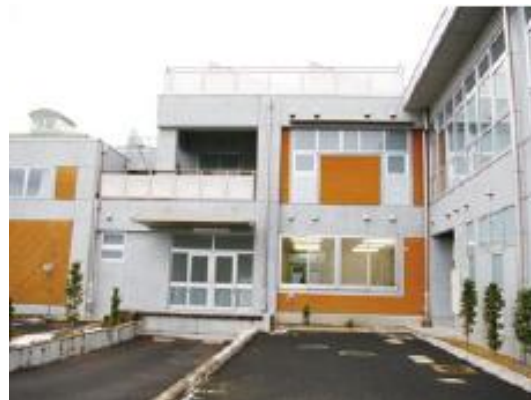
写真 5-8 左側の外壁は軒の出があり塗料の落ち無し（卓越風の風下に当たる。）
