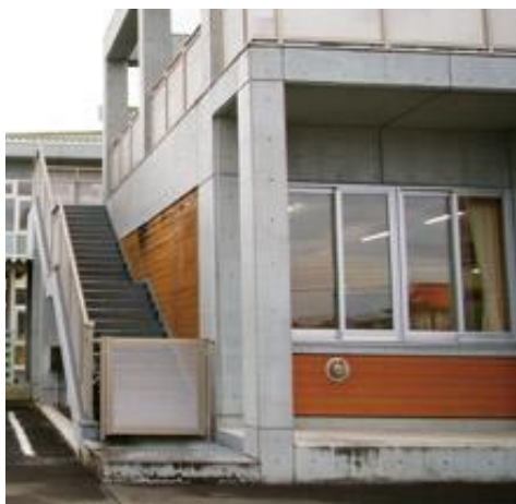
写真 5-7 北西外壁に隣接する庇下の外壁は塗料の落ちはない
