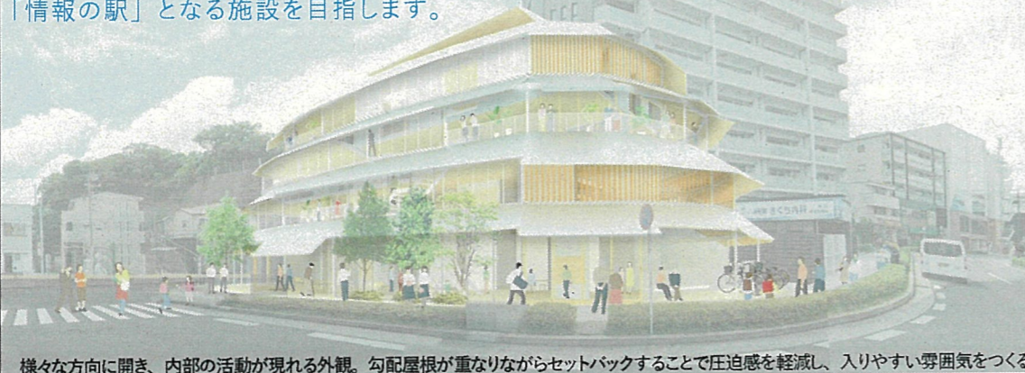
様々な方向に開き、内部の活動が現れる外観。勾配屋根が重なりながらセットバックすることで圧迫感を軽減し、入りやすい雰囲気をつくる。
