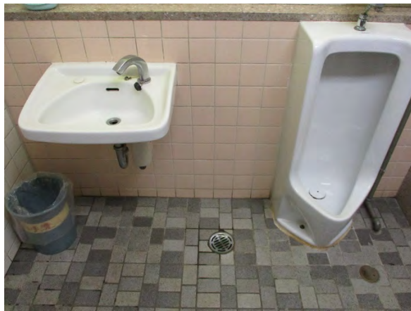
3階男子トイレ (洋便化1台・床ドライ化・段差解消)
