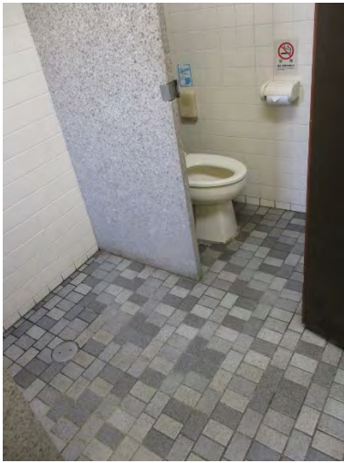
3階男子トイレ (洋便化1台・床ドライ化・段差解消)
