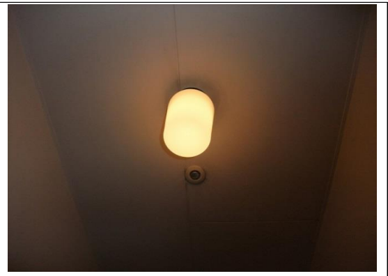
カルチャー工房更衣室側_シャワー_照明③.jpg 114
