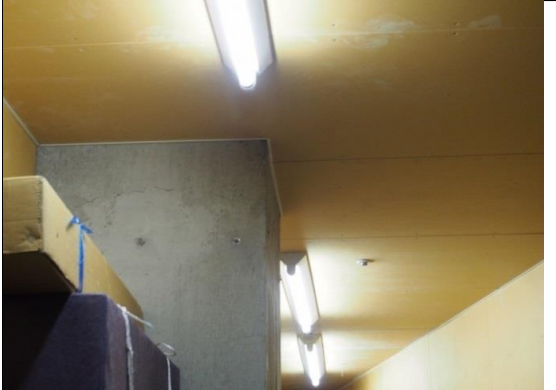
倉庫⑧-1_天井.jpg 129
