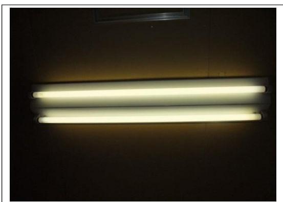
倉庫②_照明.jpg
