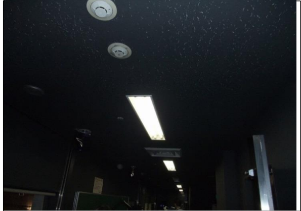
大ホール調整室_天井②.jpg
