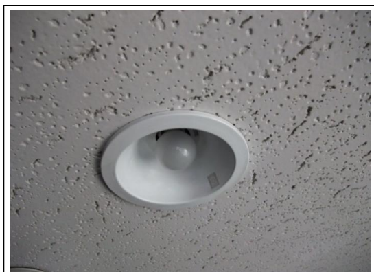
エレベーター前_非常灯.jpg
