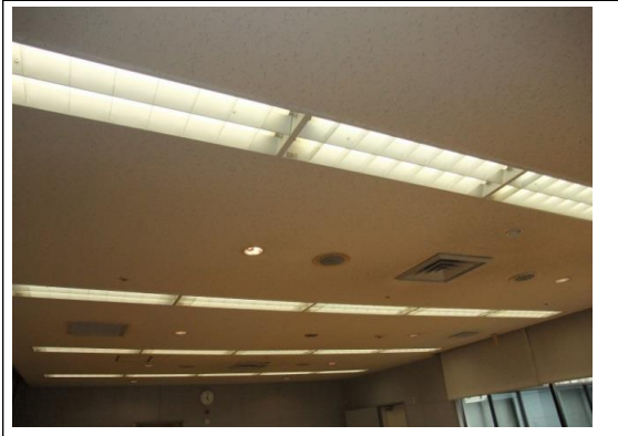
カルチャー工房_天井.jpg
