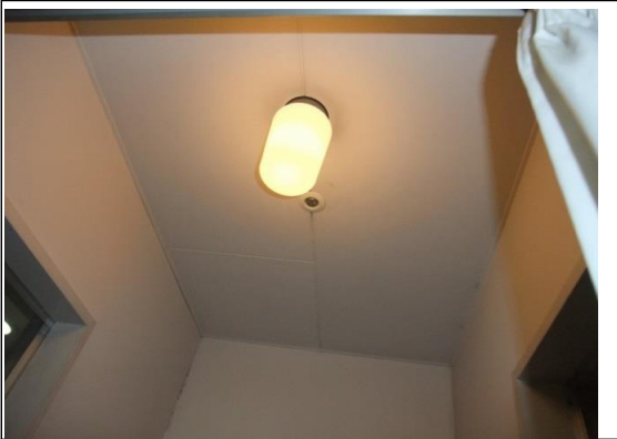
カルチャー工房更衣室側_照明2.jpg 114
