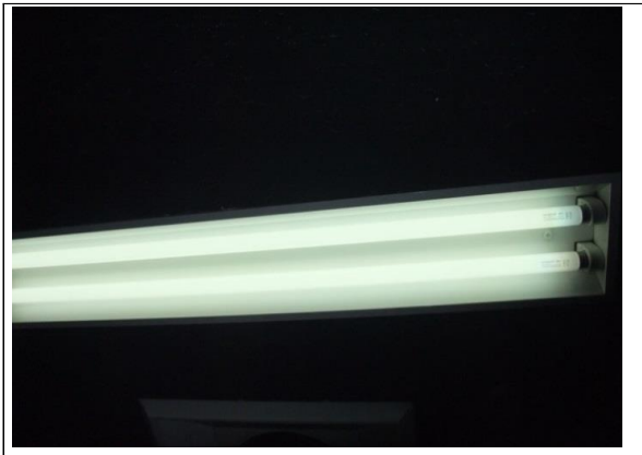
小ホール調整室_照明.jpg
