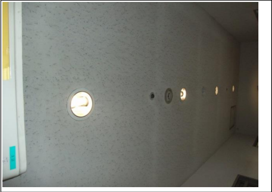
カルチャー工房更衣室側_天井.jpg 115
