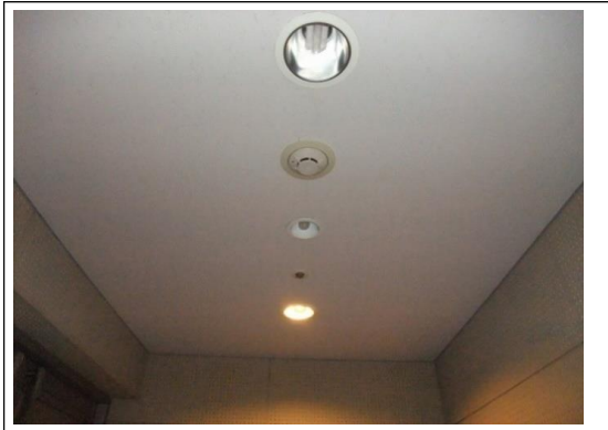
上手裏出口_(エレベータホール側)_天井.jpg 45
