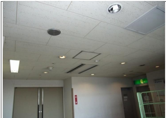
搬入口廊下_天井②.jpg
