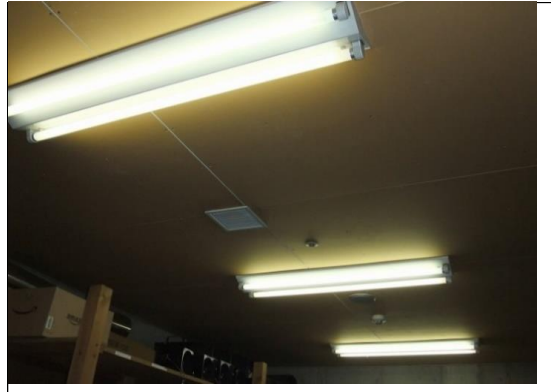
倉庫③_天井.jpg
