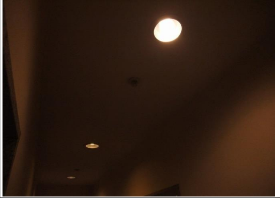
トイレ③_入り口_天井.jpg
