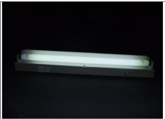
小ホール調整室下_階段_照明.jpg
