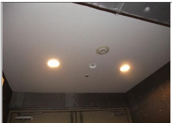
搬入口出入口_天井.jpg 46
