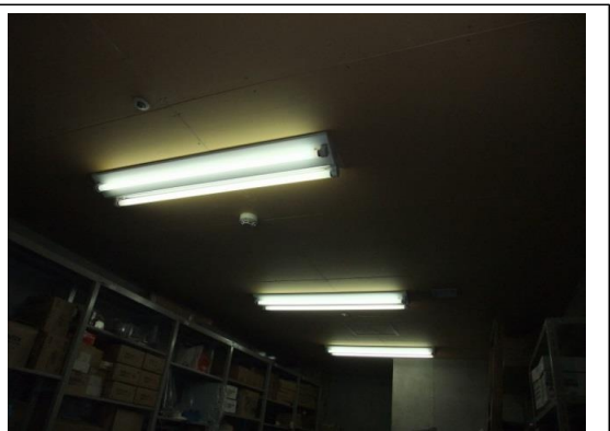
倉庫⑥_天井.jpg
