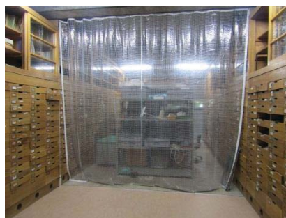
収蔵庫内改装状況
