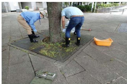
植樹マスの段差解消
