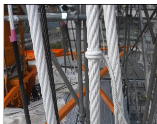
ミズンマスト バックステイ塗装
