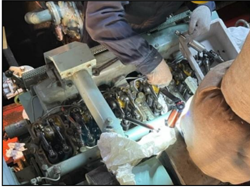
非常用発電機（原動機）開放整備
