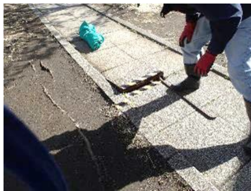
歩道ブロックの段差補修
