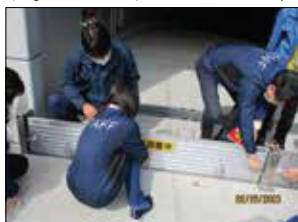
■■■公会堂での止水板の設置訓練
