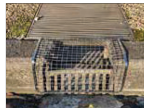
排水口のフィルターと なる排水かごの設置
