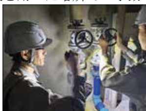
■■町総合保健福祉センターでのライフライン復旧訓練
