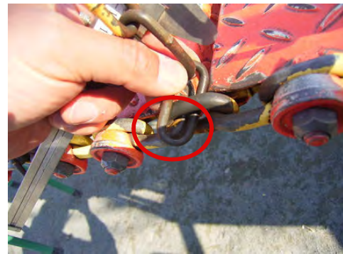
▲ 吊り橋チェーン摩耗
