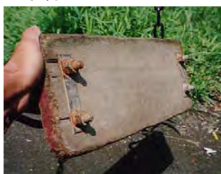
腐朽の初期段階
