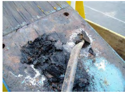
▲ 板の腐食状況
