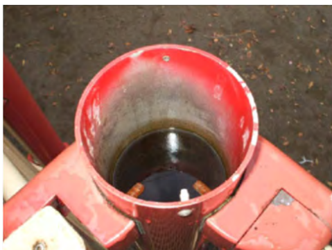
▲ 柱頂部キャップ欠落
