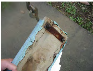
樹脂系素材の劣化状
