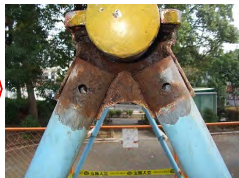
▲ ブランコ支柱継ぎ手金具取り外し状況
