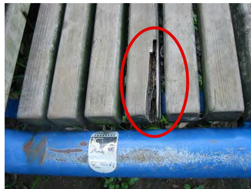
▲ 座板の腐食
