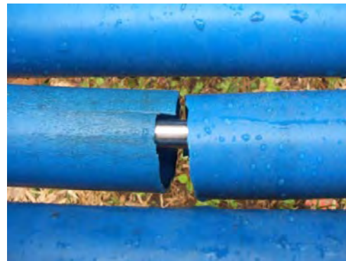
▲ ロールーすべり台のローラー破損
