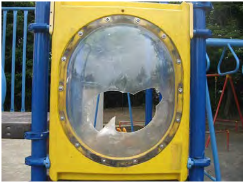
▲ ドームパネル破損
