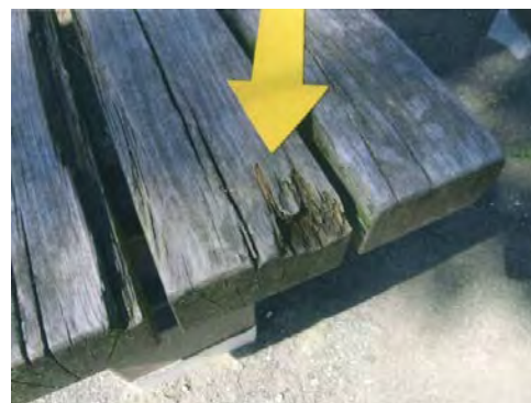
▲ 木製ベンチの腐食
