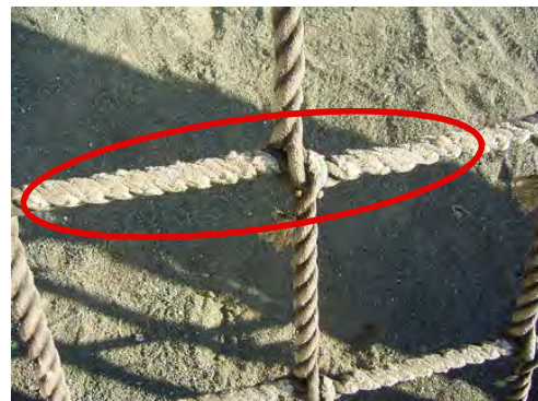
▲ ネットの破損・摩耗
