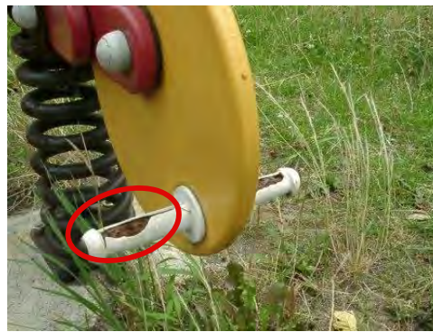
▲ 足掛部の損傷
