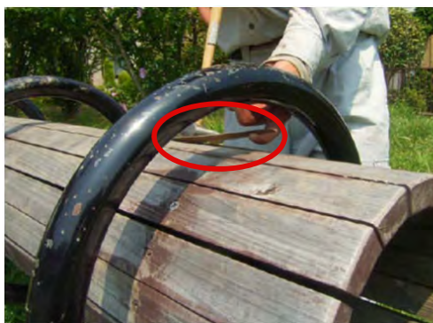
▲ 座板表面の割れ
