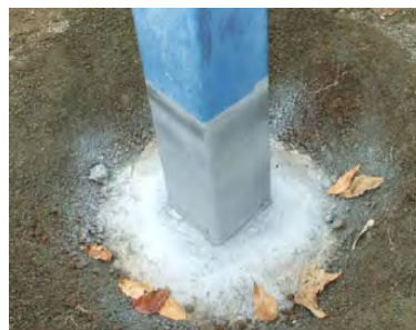
◀ 柱の根際部の 防食テープ 措置事例
