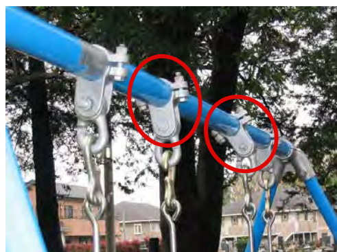
▲ 吊り金具のずれ
