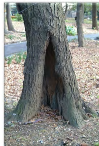
▲ 開口空洞がある樹木(※)
