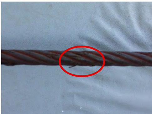
▲ ケーブルの摩耗（素線破断）
