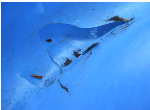
▲ スライダー滑降面の破損
