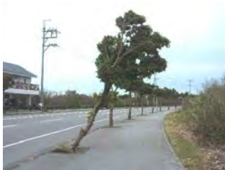
根元からの傾き（※） （先端まで傾いていると危険性高い）
