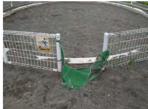
▲ 砂場柵入口の破損
