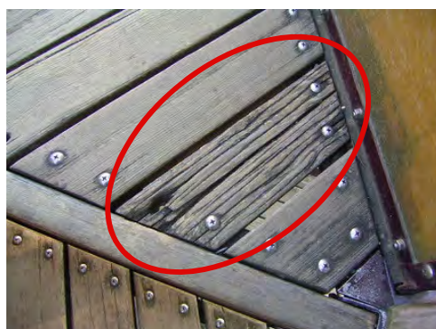
▲ 床材の腐朽
