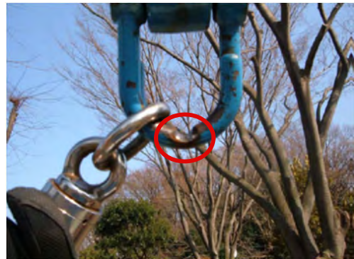
▲ 上部吊金具摩耗
