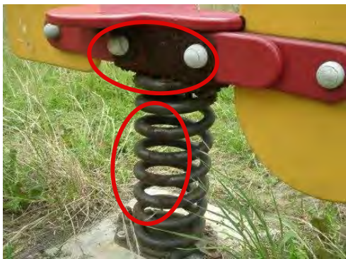
▲ スプリング及び上物取付金具の錆
