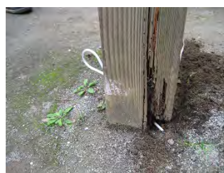
腐朽の最終段階
