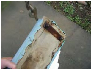
樹脂系素材の劣化状
