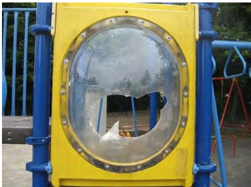
▲ ドームパネル破損
