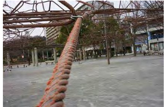
▲ ザイルネット登はん遊具のワイヤーの露出 (鋭利な状態の場合は怪我をする恐れあり)
