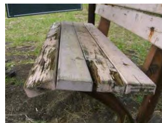
腐朽の中期段階
