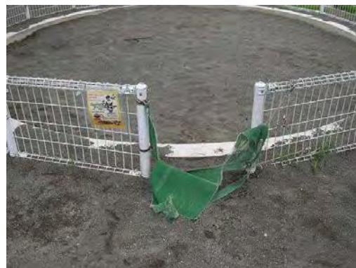
▲ 砂場柵入口の破損
