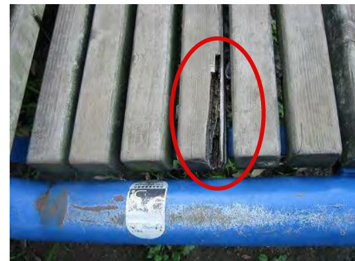
▲ 座板の腐食
