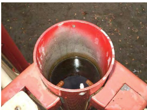
▲ 柱頂部キャップ欠落
