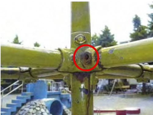
▲ ボルトの欠損（マウンテンクライマー）
