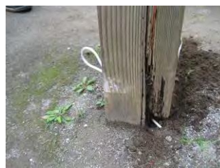
腐朽の最終段階
