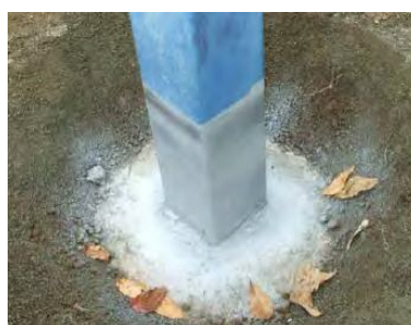
◀ 柱の根際部の 防食テープ 措置事例
