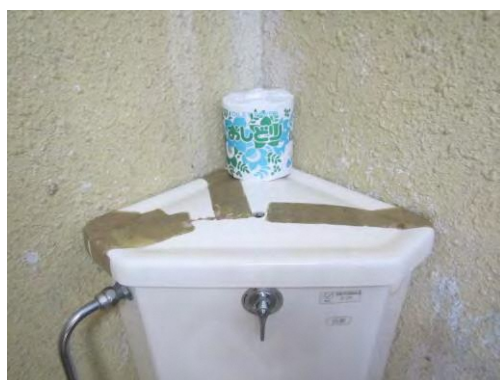
▲ 便所 タンク蓋破損
