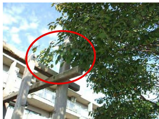
▲ 樹木の枝が支障となっている
