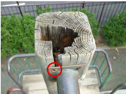
▲ 支柱天端の腐朽及びボルトの欠落
