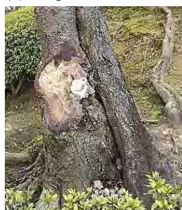
大きな切除跡の腐朽・キノコ
