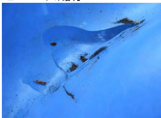
▲ スライダー滑降面の破損
