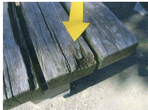
▲ 木製ベンチの腐食
