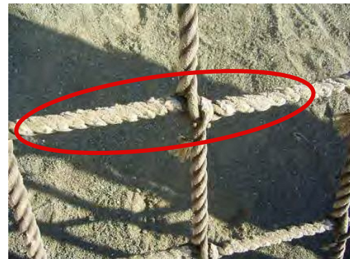
▲ ネットの破損・摩耗
