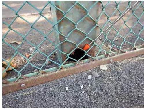
▲ 高尺フェンス 支柱穴
