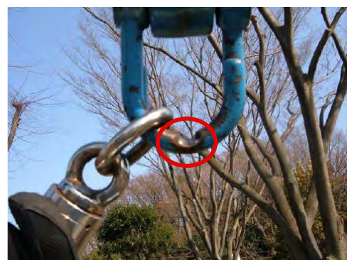
▲ 上部吊金具摩耗
