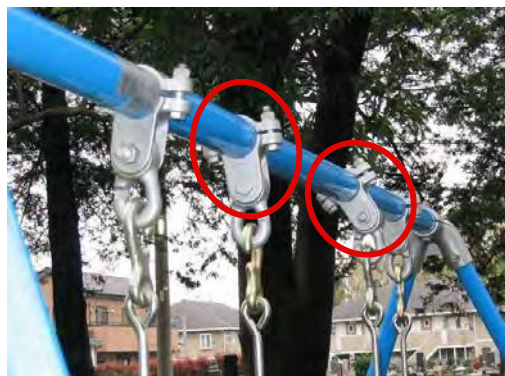
▲ 吊金具のずれ
