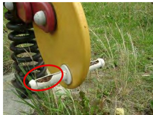
▲ 足掛部の損傷
