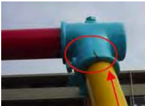
▲ 継ぎ手金具の割れ
