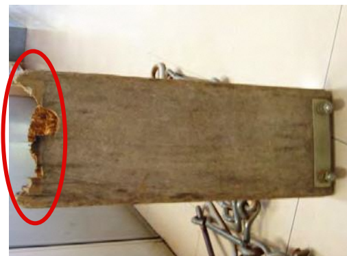
▲ 座板の腐食
