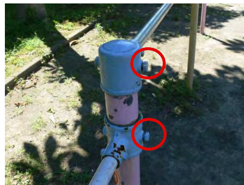
▲ ボルトの飛び出し
