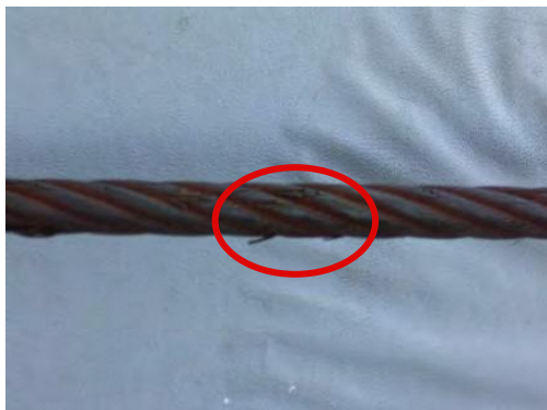
▲ ケーブルの摩耗（素線破断）
