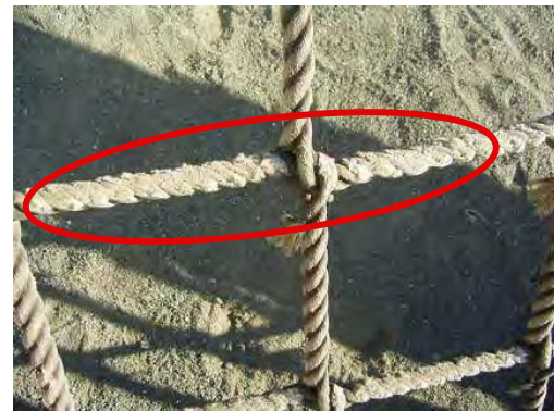
▲ ネットの破損・摩耗
