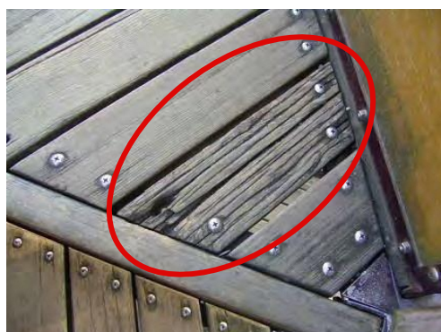
▲ 床材の腐朽
