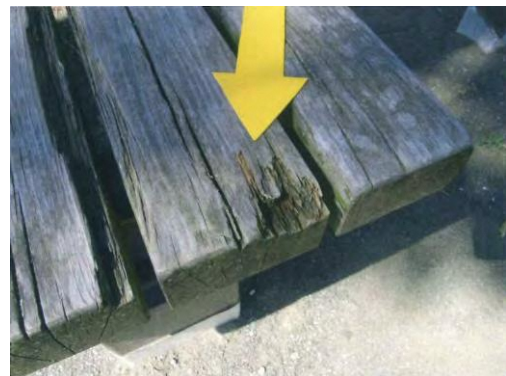
▲ 木製ベンチの腐食
