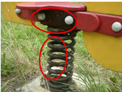
▲ スプリング及び上物取付金具の錆
