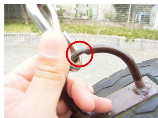
▲ タイヤ取付リングの摩耗
