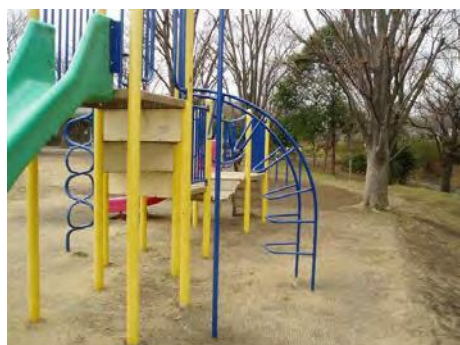
▲ 部分的な使用禁止措置の事例
