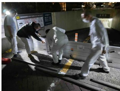
ポートサイド地下駐車場
