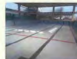
〈旭プール プール槽塗装修繕〉
