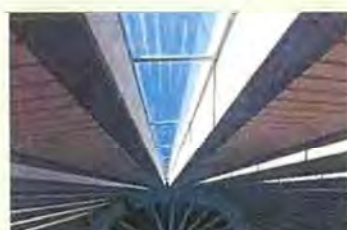
〈都筑プールの天井ガラス〉
