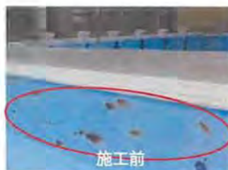
〈都筑プール プール槽塗装補修工事〉
