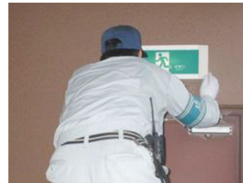
【即応した施設修繕職員】
