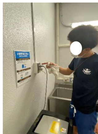
【コンセントの確認】
