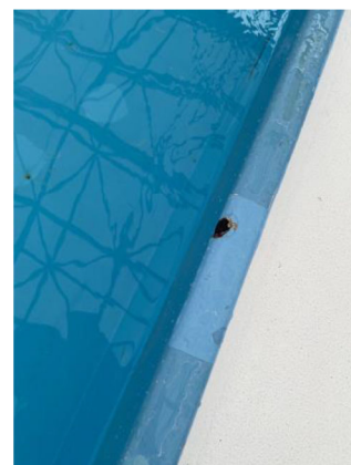
【危険箇所の確認】
