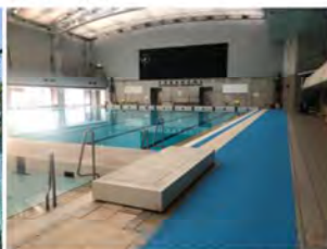
サブプールノンスリップ改修
