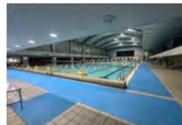
プールサイド導線への防滑加工
