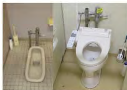
（左）工事前（和式） （右）工事後（洋式）
