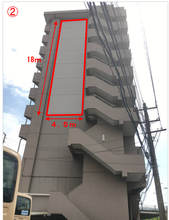
▲市営生麦住宅 外観 (北東側 線路沿い)
