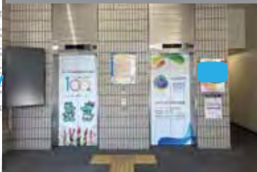
① 各階エレベーターホール（1階）
