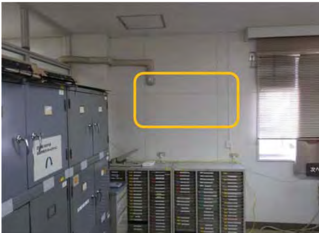
③土木事務所2階2
