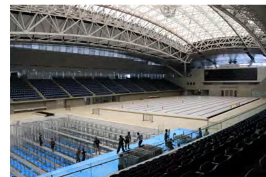
床転換工事の様子
