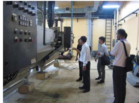
下水処理場（汚泥脱水機）現場調査
