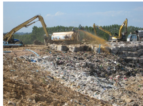
廃棄物埋立処分場現場調査
