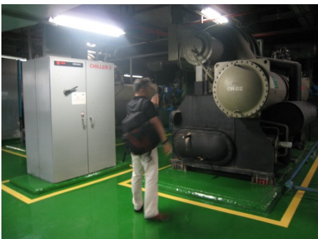
民間商業施設空調設備現場調査
