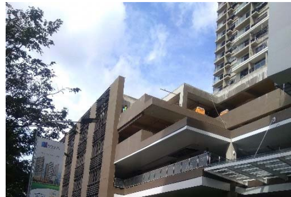
フォーラム会場および排水施設の調査先商業施設(外観)
