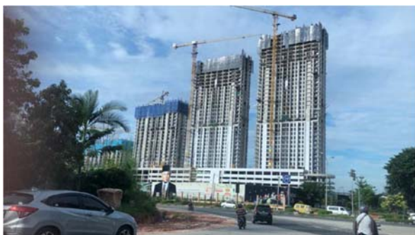
20 階を超える高層ビルの建築が進むバタム市
