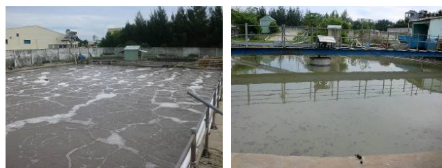
写真：ダナン市内の水産加工場からの排水処理場。 処理能力の改善があるが放流水に求められる水質基準を完全には満たしていない。
