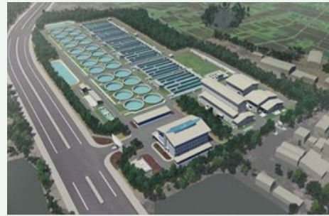
エンサ下水処理場建設事業(ベトナム・ハノイ) JFE エンジニアリング(株)(鶴見区)
