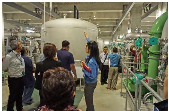
浄水設備の見学
