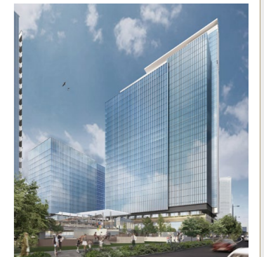
横浜シンフォステージ (53 街区) [2024 年 3 月竣工] Yokohama Symphostage (Block 53) [Completion March 2024]
