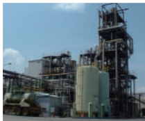
横浜工場の製造設備
