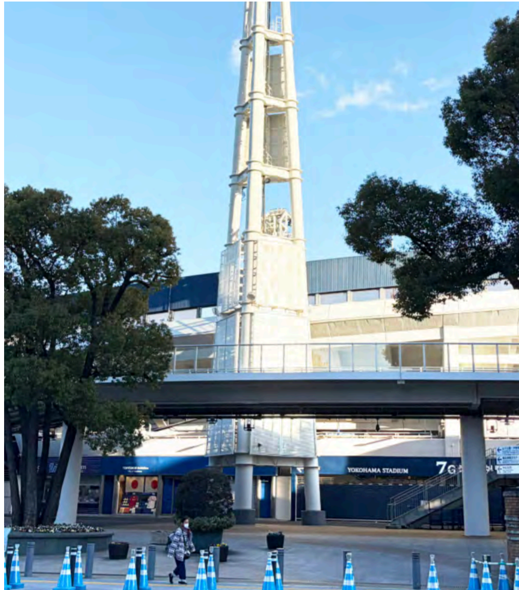
掲出がない状態
