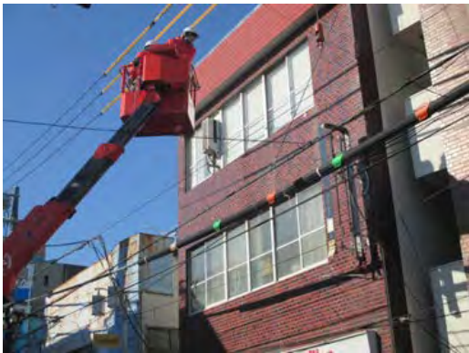
（高所作業車での取り外し作業）
