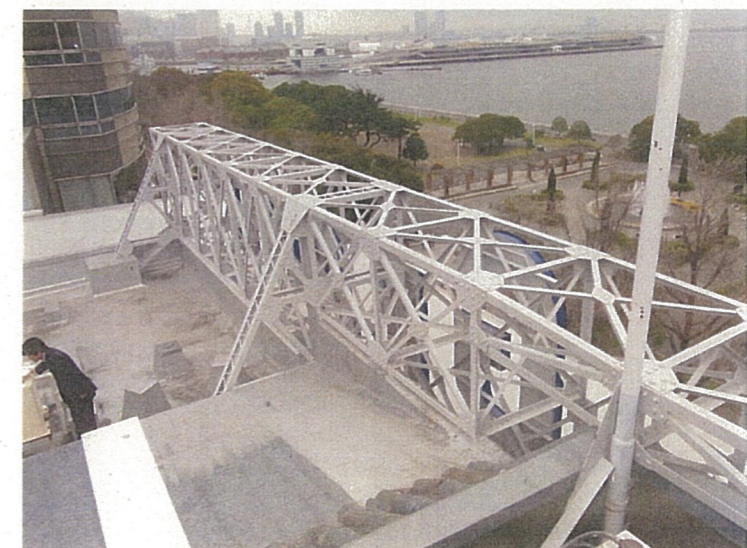
鉄骨下地外観
