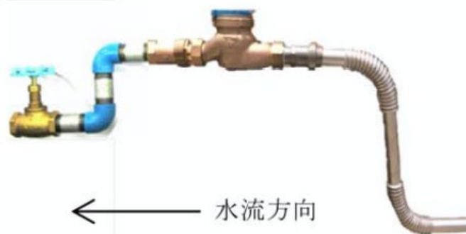
(イ) 呼び径 40 の配管例
