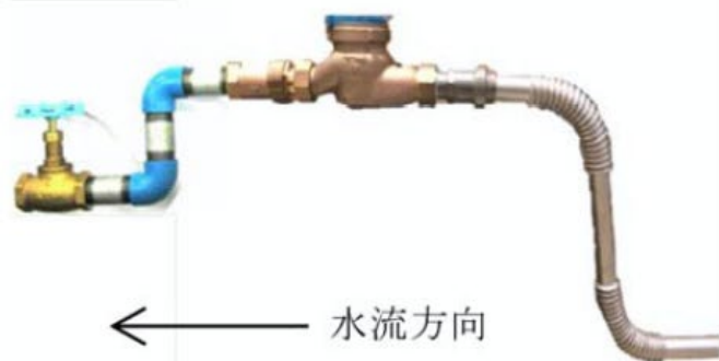
(イ) 呼び径 40 の配管例
