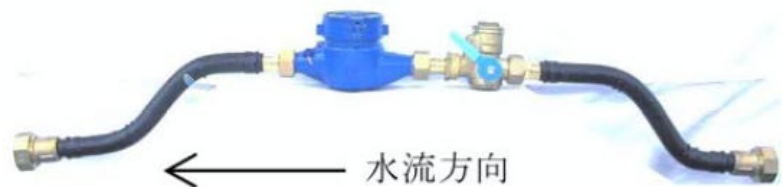
(イ) 呼び径 40 の配管例
