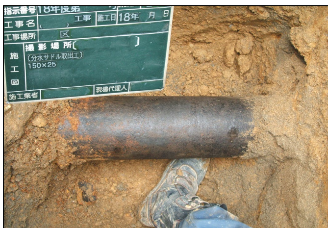
④ 給水管布設状況写真
