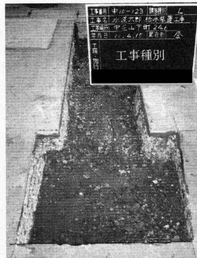
埋め戻し完了状況写真
