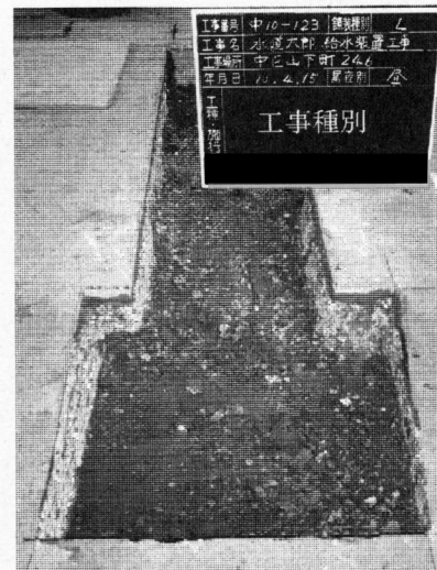
埋め戻し完了状況写真
