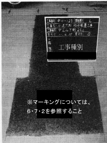
道路内仮復旧完了状況写真
