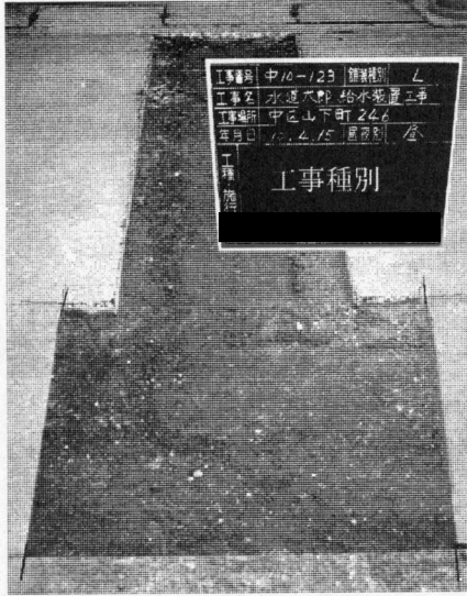
道路内路盤工完了状況写真
