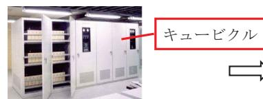
\*1 鋼板で造られた外箱に収納されている方式
