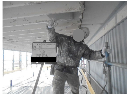
外壁屋根塗装工事
