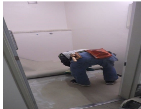
内装改修工事
