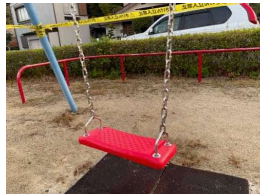
本格的な措置として座板等の交換を実施
