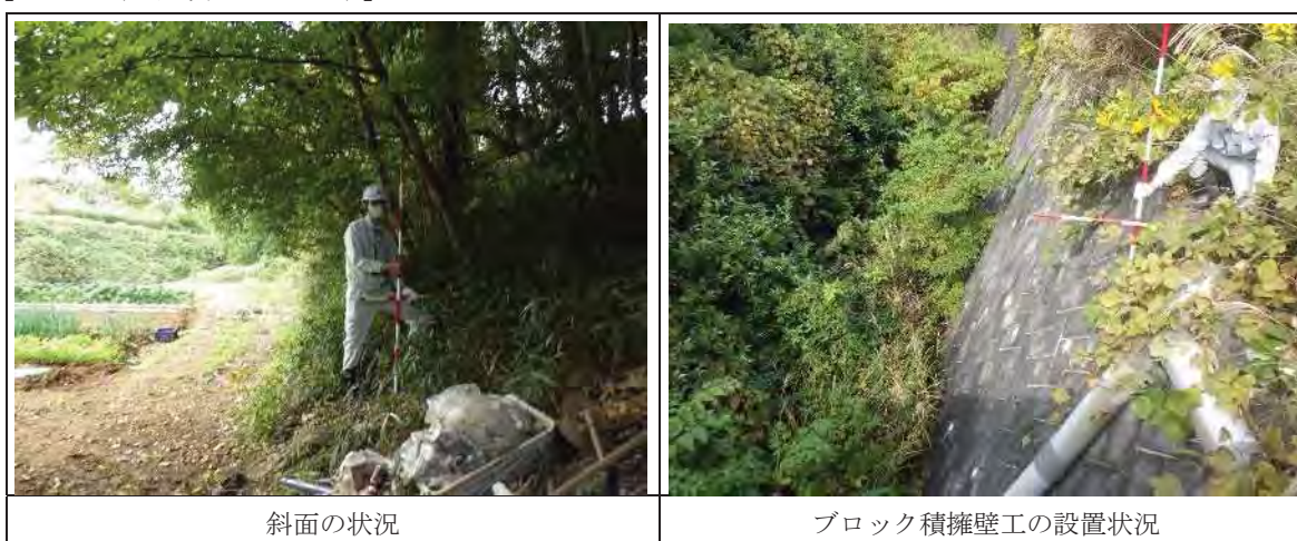
写真 9.8-1 土砂災害警戒区域の状況
